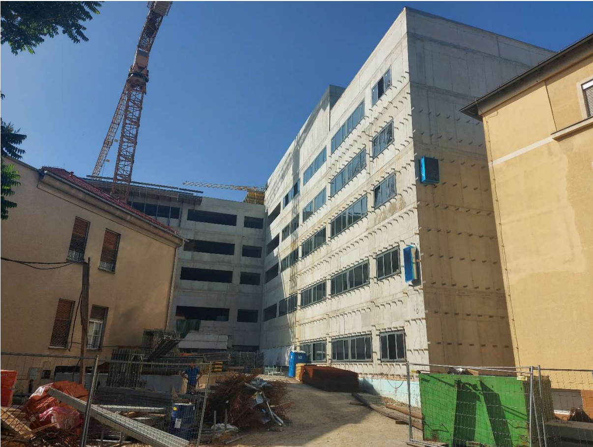
Slika 2: Aktualno stanje na gradbišču Etape 1 (junij 2021)
